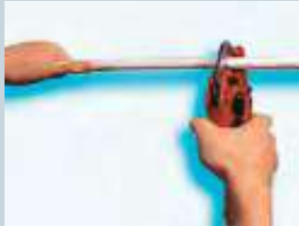
2. Corte la tubería
