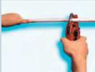
2. Corte la tubería
