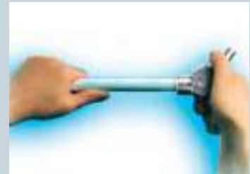
3. Redondeo y rebaje de la sección de entrada: Gire alrededor del tubo la herramienta para abocardar la tubería multicapa Polysan, para que el accesorio pueda entrar en él fácilmente
